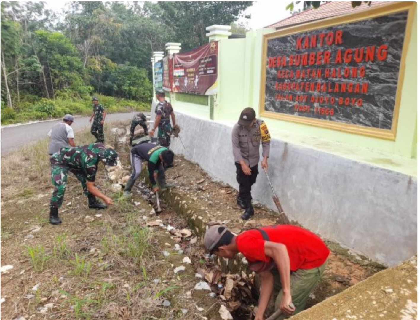
Tanggap Bencana, Koramil 1001-12/Halong Bersihkan Saluran Air
